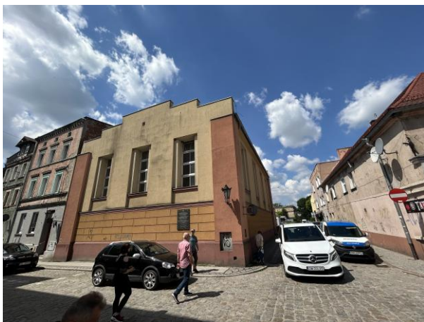
Das Gebäude der früheren Synagoge
