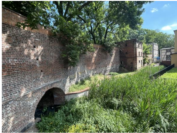
An der alten Stadtmauer mit Blick auf die Mühle
