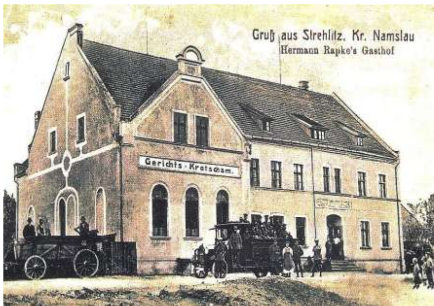
Strehlitz (Gasthof erbaut 1907)
